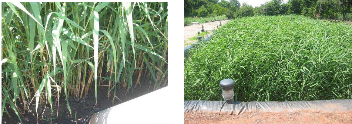
Figure 27 : représentation de lits avec une densité de tige supérieure à 250/m 2 (crédit photo ARPE PACA)
