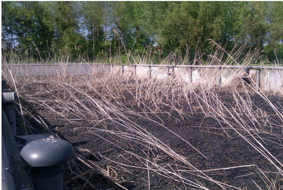
Surcharge au démarrage (50 kg MES/m 2 /a) et nombre insuffisant de lits (4). Photo Irstea
