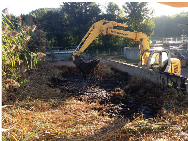
Curage sur casier béton (crédit photo : Alliance Environnement)
