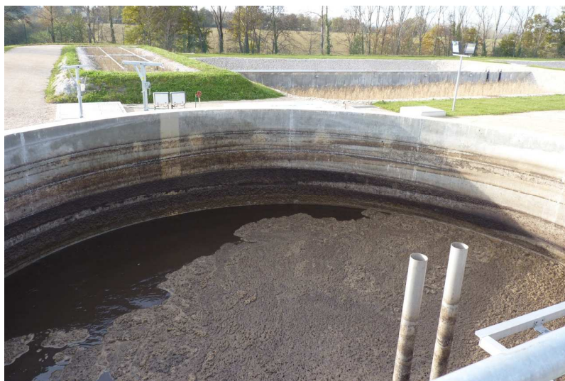
Figure 18 : photos de la cuve de stockage (6 jours) avec agitateur et hydroéjecteurs de la station de Nègrepelisse (11 000 m 3 /an)
