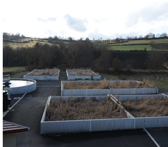
b) LSPR de Saint Paulien (1 900 EH, 43) en casiers béton (hiver). photo CG 43
