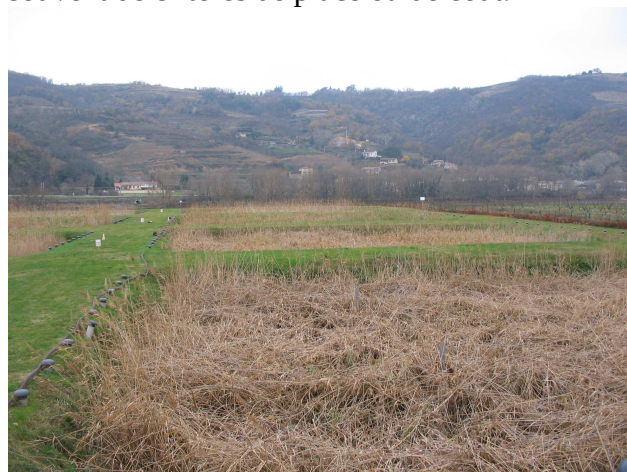
a) LSPR d'Andancette (13 000 EH, 26) en déblais remblais (hiver). photo Irstea
