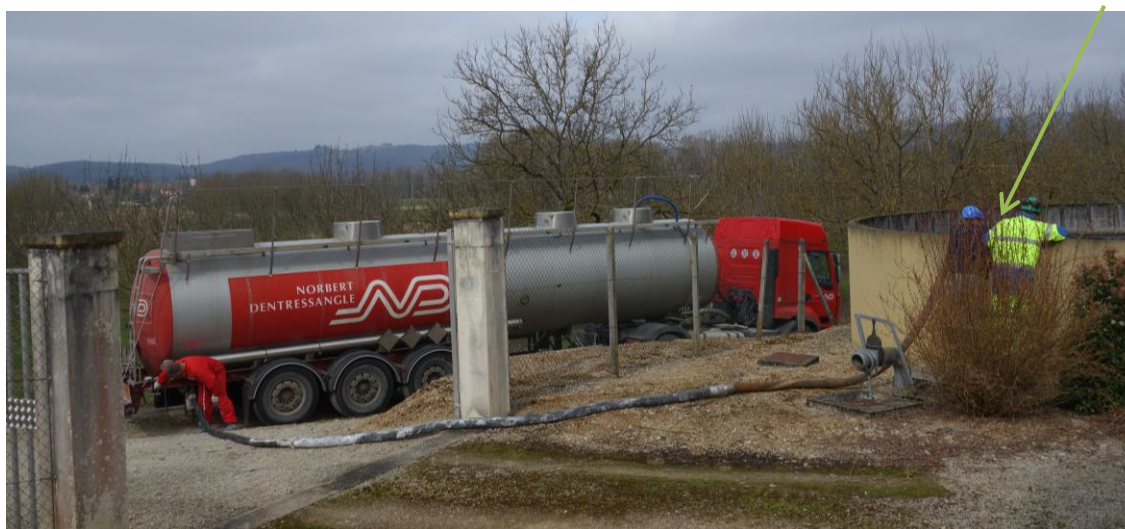
Figure 1 : Vu d'ensemble de l'injection de lait de chaux
