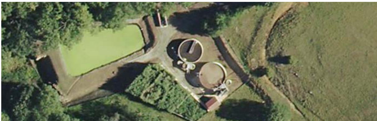
Figure 12 : Vue aérienne de la station d'épuration de Labastide-Murat. Source : Géoportail.
