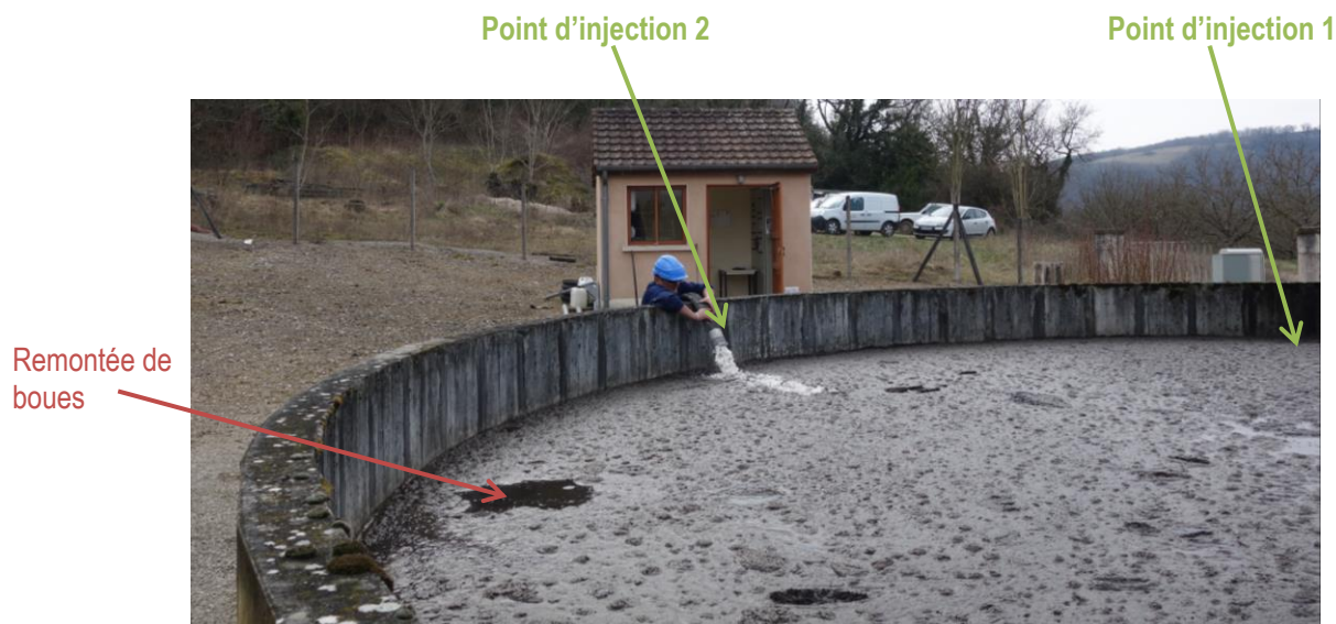
Figure 2 : Points d'injection du lait de chaux
