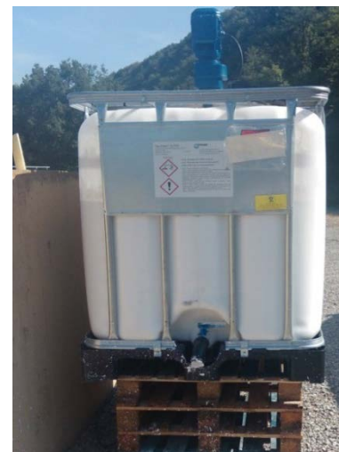
Figure 40 : Dispositif de chaulage des boues en routine à la STEU de Meyronne-Creysse.
