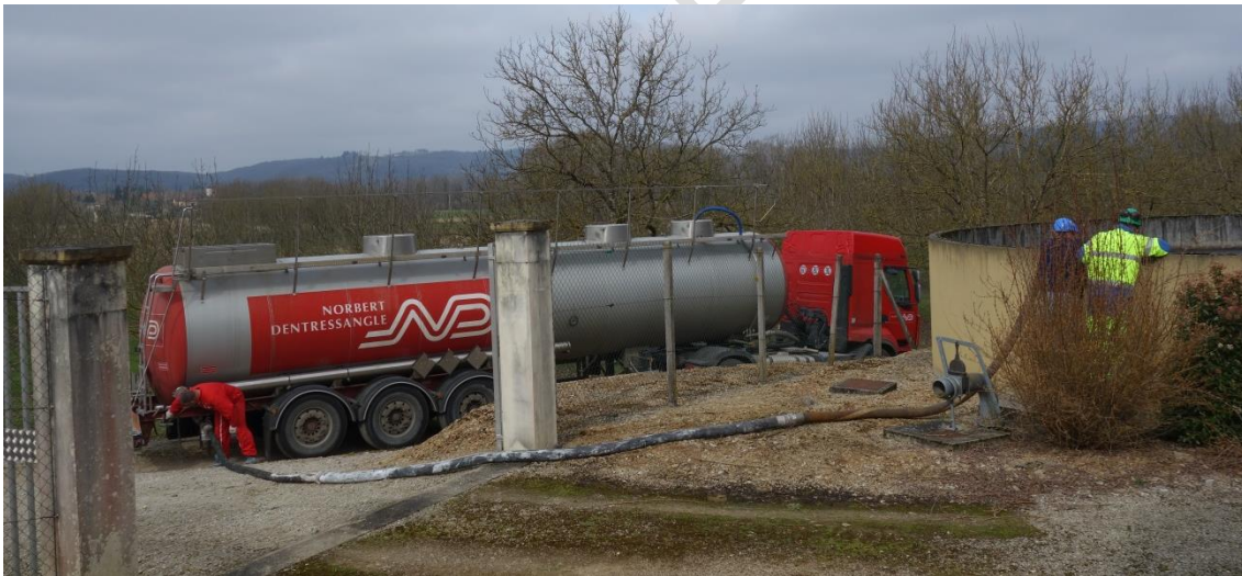
Figure 1 : Vue d'ensemble de l'injection de lait de chaux
