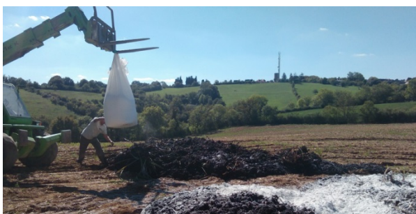
Figure 43 : Chaulage des boues de la STEU de Labastide-Murat.
