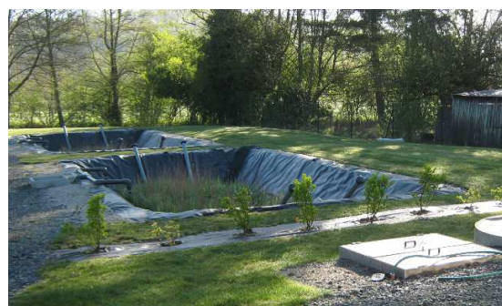
Lits de clarification séchage plantés de roseaux
