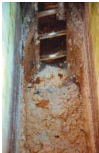
Photo 7 – Arrivée de graisses sur un tamis statique.
