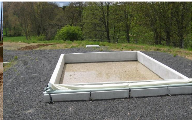
Filtre B : Station de Coren. Filtre à écoulement vertical descendant avec flaquage en surface
