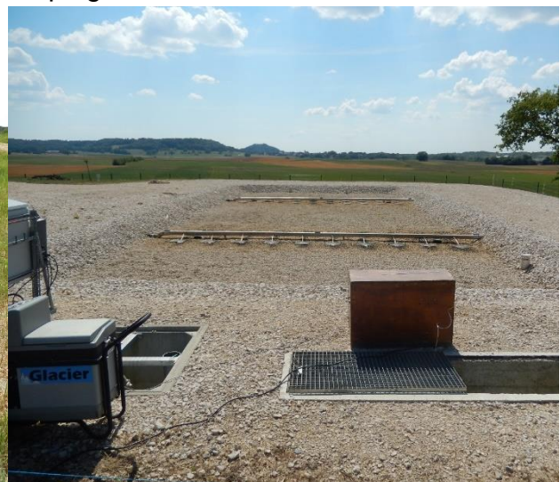
Filtre B : Station de Coren. Filtre à écoulement vertical descendant avec flaquage en surface
