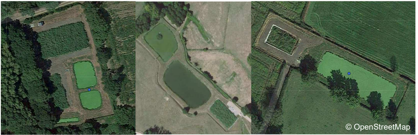
Figure 26 : Exemple de lagunes réhabilitées avec un FPRv en tête de station
