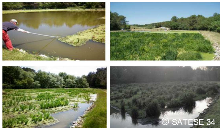
Figure 30 : Couverture flottante végétalisée de lagunes
