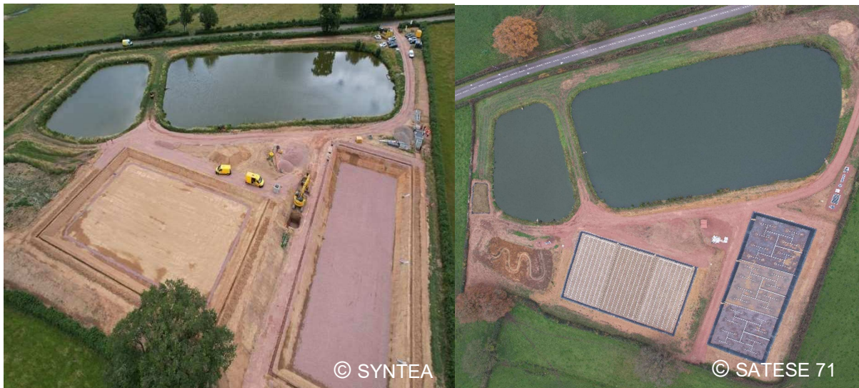
Figure 27 : Construction de 2 étages de FPR lors de la réhabilitation d'une lagune avec conservation de 2 lagunes
