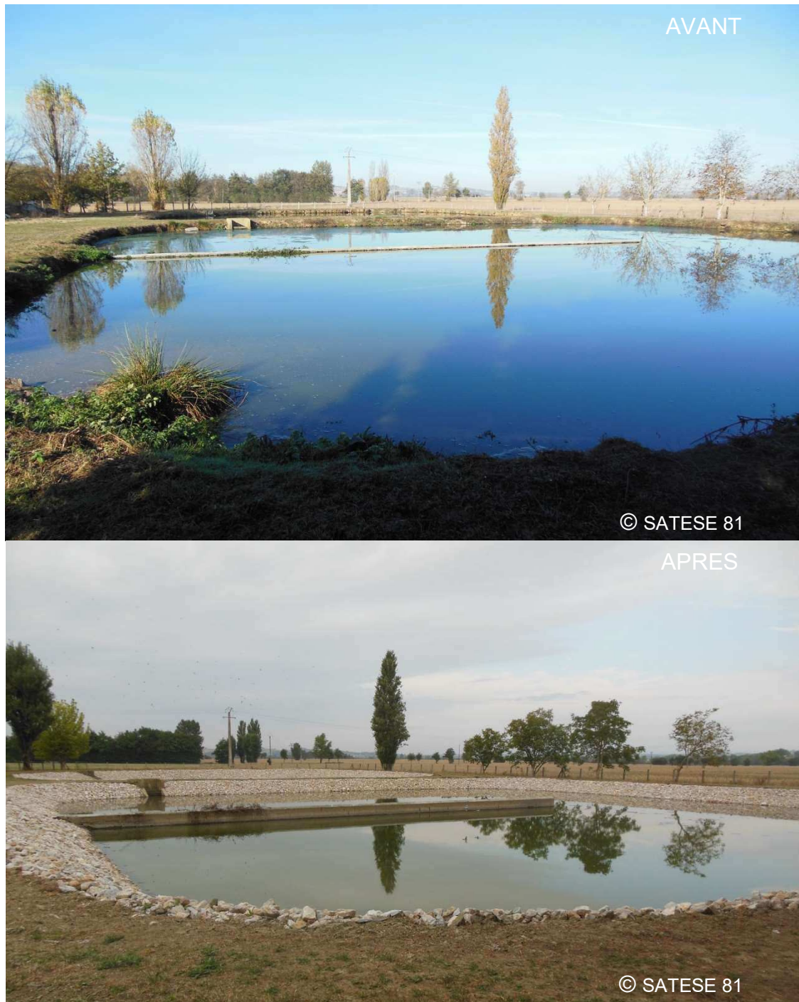
Figure 15 : Lagune avant/après la réhabilitation des berges
