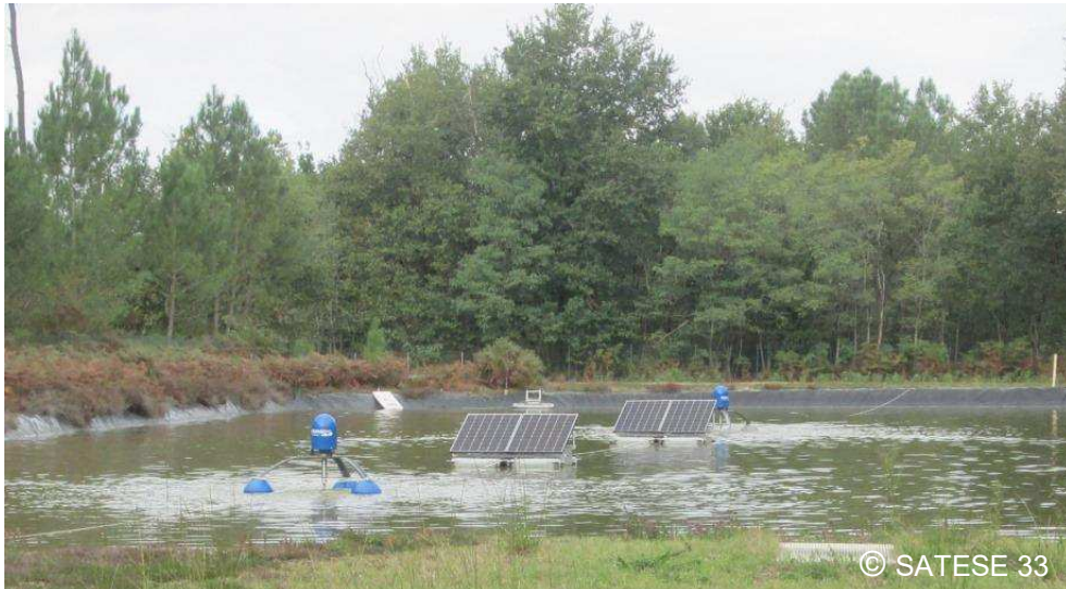
Figure 33 : Ajout de turbines de surface alimentées par des panneaux solaires sur une lagune 1
