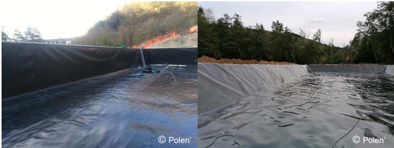
Figure 20 : Exemple de géomembranes en PP-F (gauche) et PEHD (droite)
