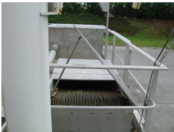
Photo 3 : dégrilleur automatique
