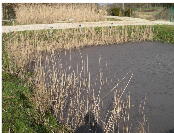
Photo 6 : Développement contrarié des roseaux en raison de doses trop élevées à Athée sur Cher en mars 2009 (37)
