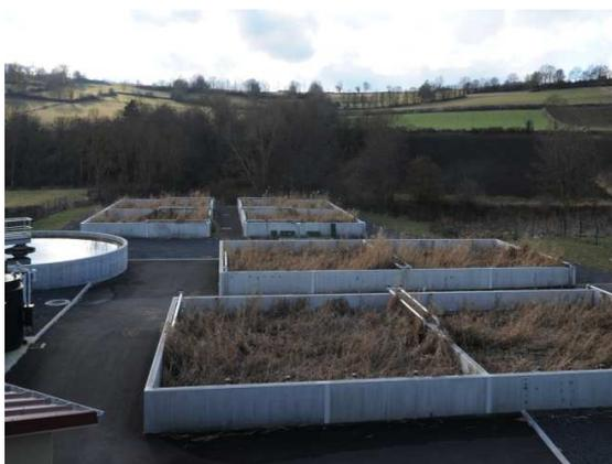
Les lits sont constitués d'un granulat sur lequel une fine couche de compost ou de sable aura été mise en place. Cette dernière couche garantit une bonne filtration dès le démarrage de l'installation. Dans le cas de compost, une meilleure croissance des roseaux est observée au démarrage mais une efficacité moindre de filtration. Une fois la couche de boues formée, aucune différence n'est observable.
