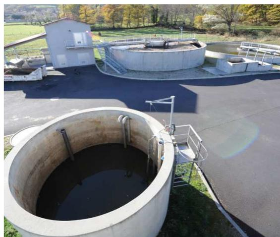
Selon la file boues en place, à l'issue des 24 h d'épaississement, les boues doivent être, soit transférées dans un silo de stockage de boues liquides, soit traitées par déshydratation (centrifugation, filtre à bandes). La siccité des boues ainsi épaissies est de l'ordre de 2 à 3%.
