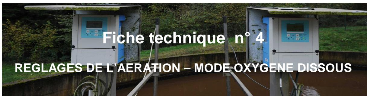
L'asservissement de l'aération à un capteur Oxygène dissous, permet d'adapter les apports en O<sub>2</sub> aux variations de charges de pollution, et aux besoins de la biomasse. Cette configuration est particulièrement utile, dès lors que la station reçoit des effluents autres que domestiques, et s'avère quasi indispensable dans le cas de réseau unitaire.
