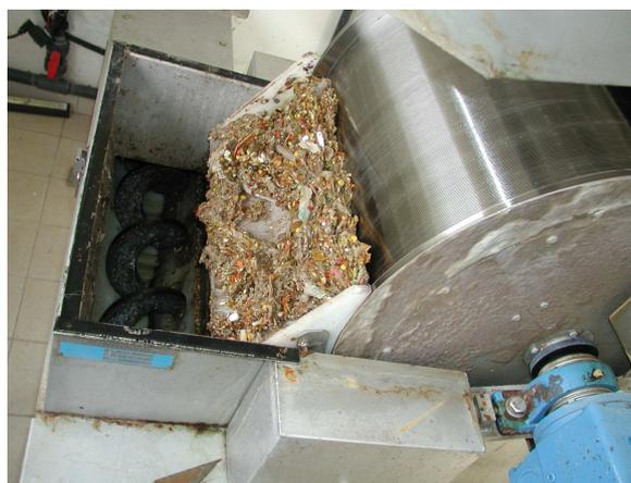
L'expérience montre que dans bien des cas, ce type de dispositif nécessite des nettoyages à haute pression, notamment lorsque les eaux usées sont riches en graisses. Par ailleurs, on observe une usure prématurée des pièces lorsque les sables sont mal gérés en amont et de possibles dysfonctionnements lorsque l'ouvrage n'est pas suffisamment protégé contre le gel.
