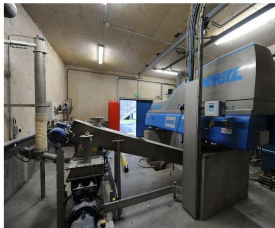
Enfin, afin de veiller au bon fonctionnement de la centrifugeuse, l'exploitant porte une attention particulière aux éléments tels que l'absence de fuite, la tension des courroies, la température, l'absence de bruits anormaux.
