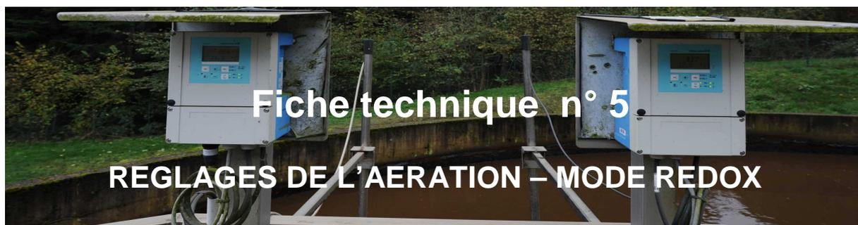
L'asservissement de l'aération au capteur Potentiel d'oxydoréduction (Rédox) permet d'adapter les apports en O<sub>2</sub> aux variations de charges de pollution, et aux besoins de la biomasse. Cette configuration est particulièrement utile dès lors que la station reçoit des effluents autres que domestiques, ou qu'elle est sujette à de fortes variations saisonnières de charges.
