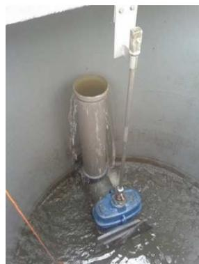
Figure 13 : Système de mise en charge permanent (Té PVC) avec vanne de vidange accessible avec canne (SATESE 16)
