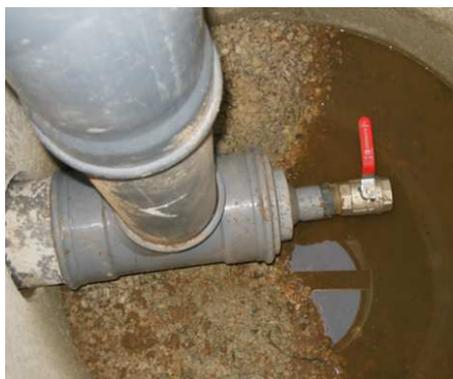
Figure 12 : Système de mise en charge amovible (Té PVC) avec vanne de vidange (SATESE 81)
