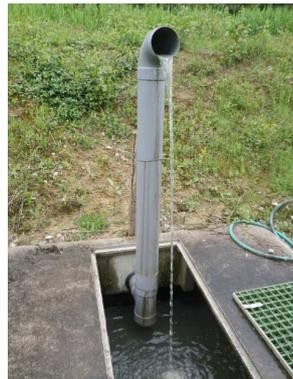
Figure 11 : Systèmes de mise en charge amovibles simples (tuyau et coude PVC) (ATD 24, CD 09)
