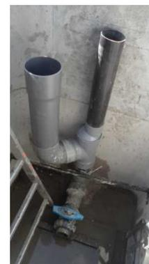
Figure 14 : Système de mise en charge permanent (Té PVC) avec vanne de vidange accessible (ARPE PACA)
