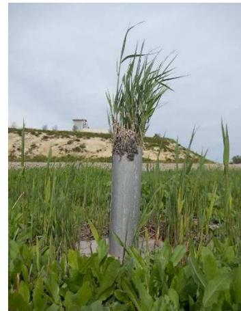
Figure 32 : Obstruction de canalisation d'alimentation par des roseaux (Irstea)
