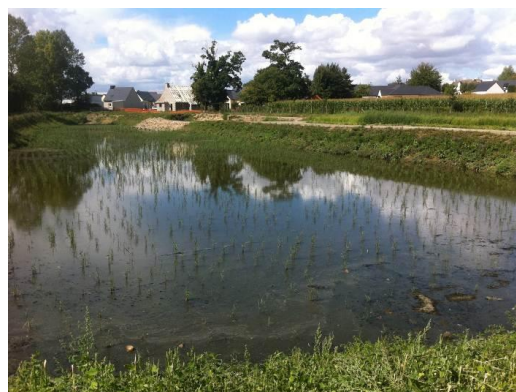
FIGURE 2: FILTRE PLANTE EN EAU, LAMBALLE (22) POUR LE TRAITEMENT DES EAUX PLUVIALES STRICTES (PHOTO SINBIO)
