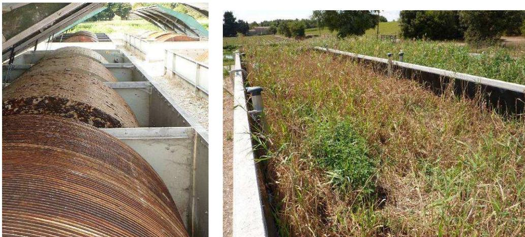
**Figure 2 – Vue des files de disques et LCSPR de la station de Montségur sur Lauzon (26) (Photos IRSTEA)**
