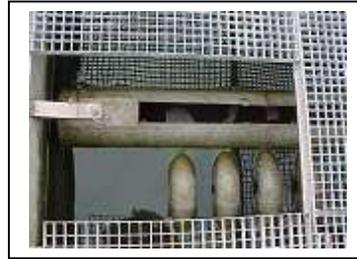
Sur le site 305, de fréquents dysfonctionnements du dispositif de bâchées ont entraîné des altérations de l'alimentation des massifs filtrants avec répercussions sur le traitement de l'azote en particulier
