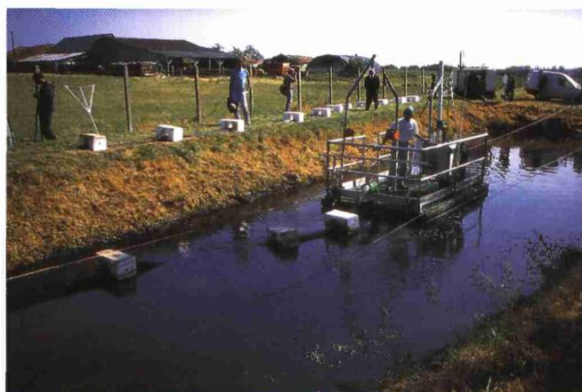
Exemple de pompage de boues à partir d'un radeau spécialement équipé
