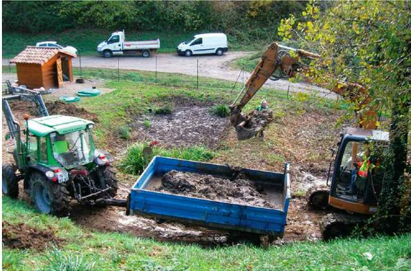
Figure 14. L'envasement des ZRV nécessite un curage.
