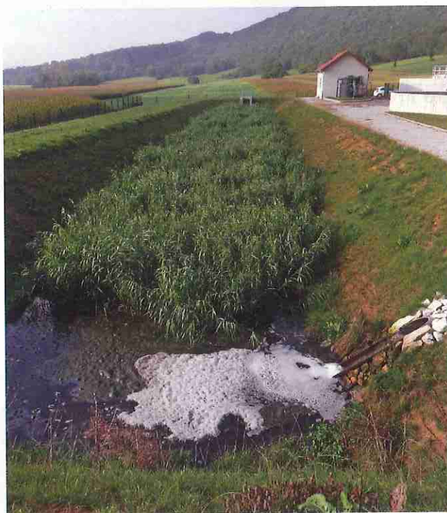
Pour Gilles Malamaire de l'Arpe Paca, le coût d'entretien est de 5 000 euros par an pour un bassin en sortie d'une Step de 5 000 EH.
